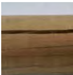
Cracks/Grietas/Fente/Risse/ Crepe/ Barsten/Fendas
