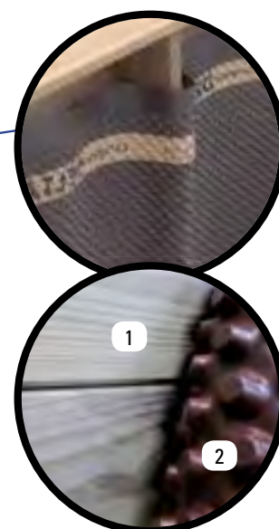
1- Holzgestell 2- Schutzrolle und alveolare Drainage aus Polyethylen hoher Dichte
